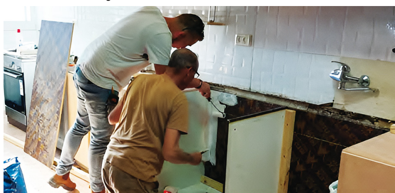
Wiederaufbau beschädigter Häuser
